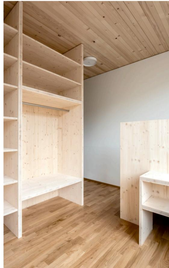
**Material und Bauweise** Die Häuser werden in Holzelementbauweise errichtet und mit einer ansprechenden Kombination aus Holzschalung und Schindeln gestaltet. Die Elemente und Decken werden mit regionalem Holz in bewährter Bauweise hergestellt. Die CO<sub>2</sub>-optimierte Bauweise ermöglicht eine Systemtrennung für nachhaltigen Bau und Unterhalt. Es wird bewusst auf Trockenbauweise gesetzt, um die Emissionen der Baumaterialien und beim Transport möglichst gering zu halten.
